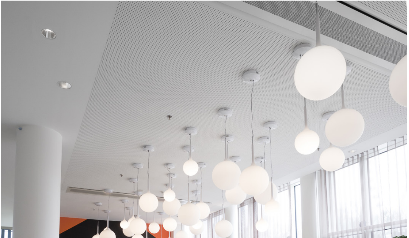
Billede 1. Integreret aktiv kølebaffel Professor XP tilpasset i nedhængt loft.
